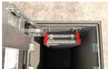
Vstup do prepadovej dažďovej nádrže
