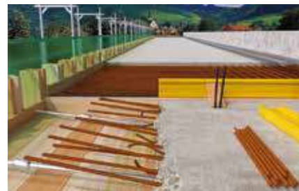
Vlepované betonárske výstuže
