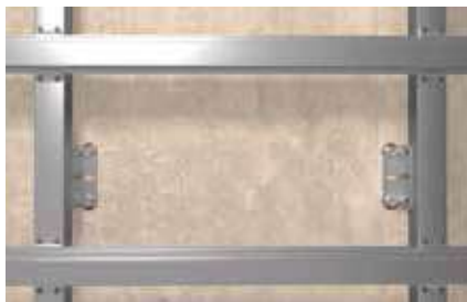
Kovová fasádna pod-konštrukcia
